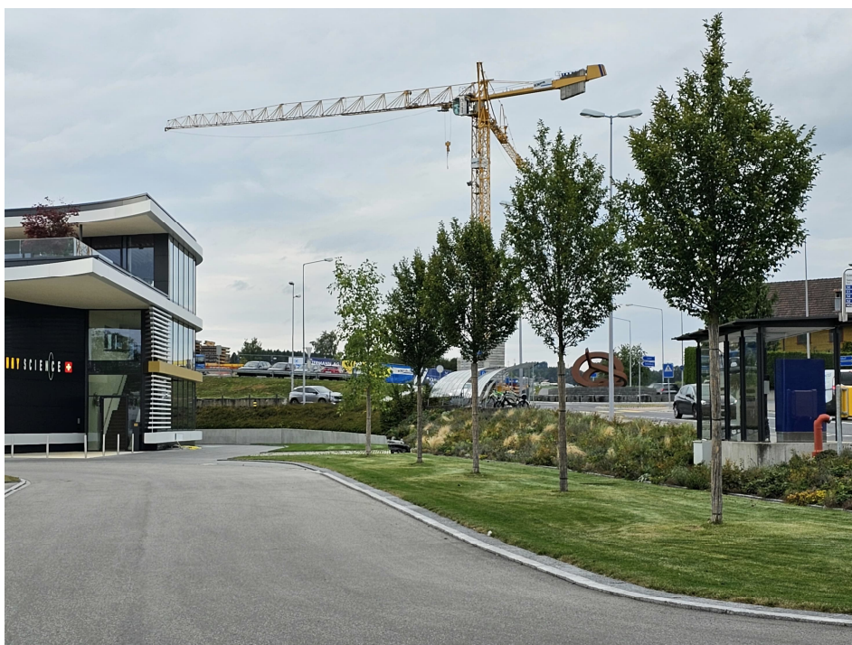
Abb. 12: Foto Baumallee und Grünfläche Bepflanzung Einfahrt
